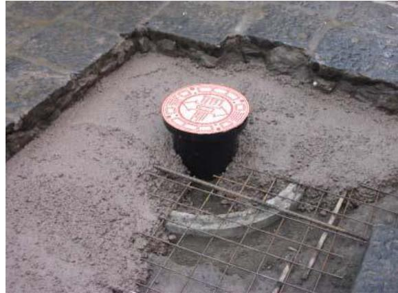
Verlegen Sie die Baumstahlmatten und füllen Sie diese mit Beton auf.
