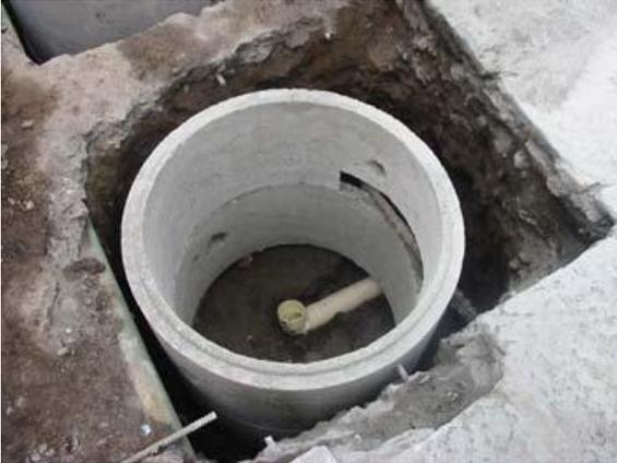
Positionieren Sie das vorgefertigte Zementrohr und das Entwässerungssystem.
