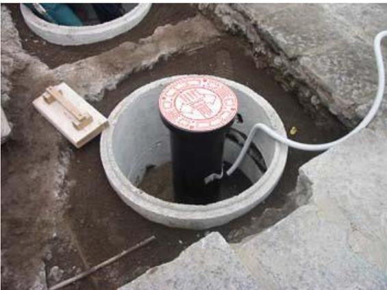
Kleben Sie die Schutzpappe auf dem Flansch und installieren Sie den Poller. Der Pfeil auf der Schutzpappe gibt die Laufrichtung vor.
