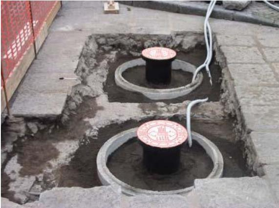
Verfüllen Sie das vorgefertigte Zementrohr mit Sand und richten die Zuleitung entsprechend aus.
