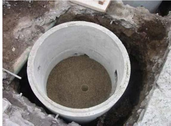
Anschließend bereiten sie den Boden und die Einbauhöhe mit Sand vor.
